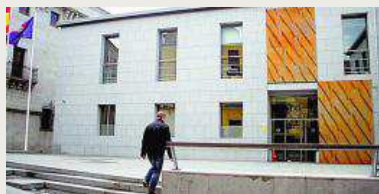
Edificio de juzgados de Ávila.
